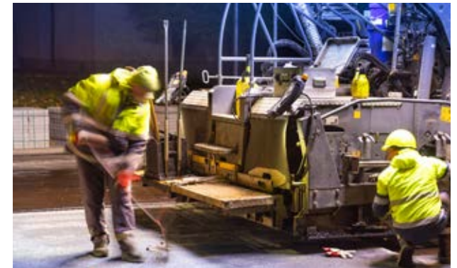
Events en wegwerkzaamheden
